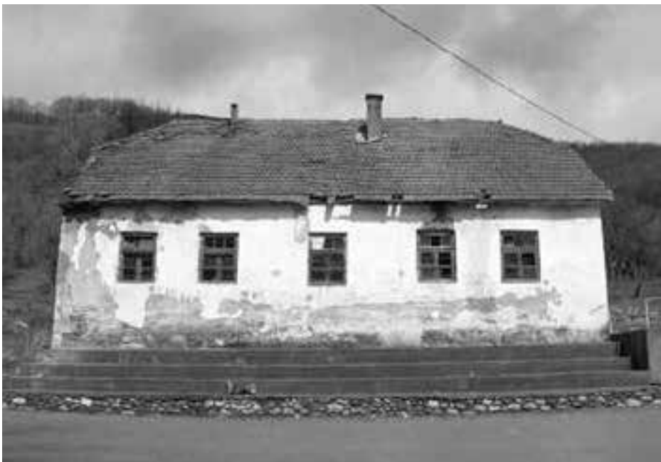
Zgrada škole u Velici, podignuta poslije Drugoga svjetskoga rata
