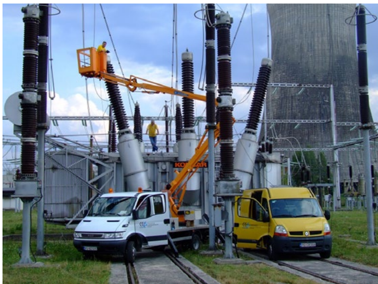
Slika 5.1. Montaža elemenata visokonaponskih razvodnih postrojenja
