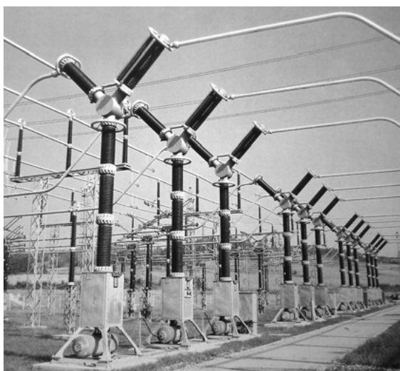
Slika 5.9. SF6 prekidači montirani u 400 kV postrojenju
