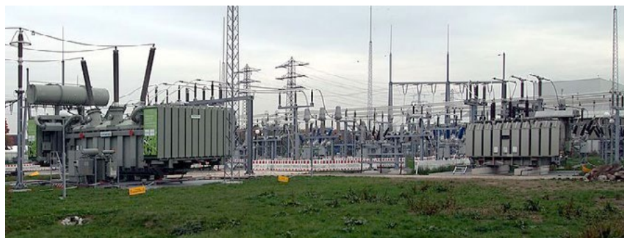
Slika 2.1. Energetski transformatori u sklopu VNRP: a) 400/110 kV, b) 110/20 kV
