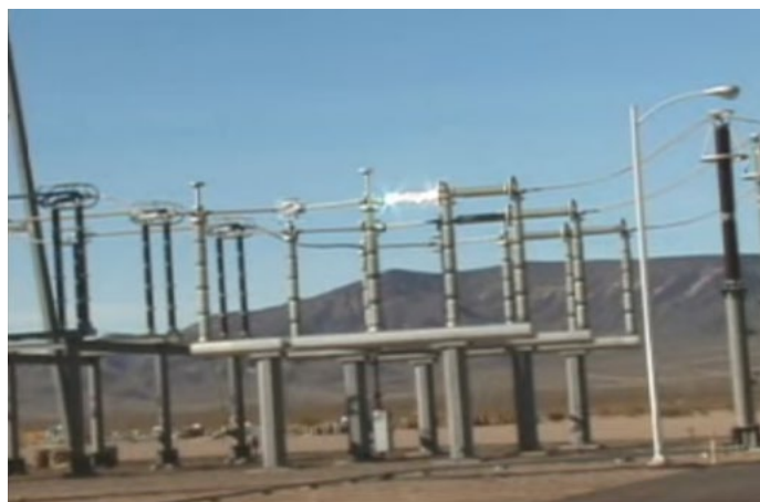
Slika 4.7. Različiti oblici električnog luka usljed isključenja 400 kV rastavljača pod naponom
