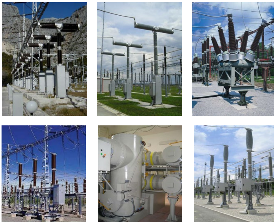
Slika 1.35. Različiti tipovi VN SF 6 prekidača ugrađeni u VNRP
