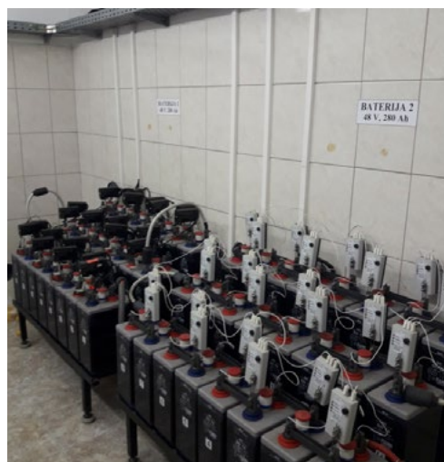
Slika 1.54. Postrojenje jednosmjernog razvoda
