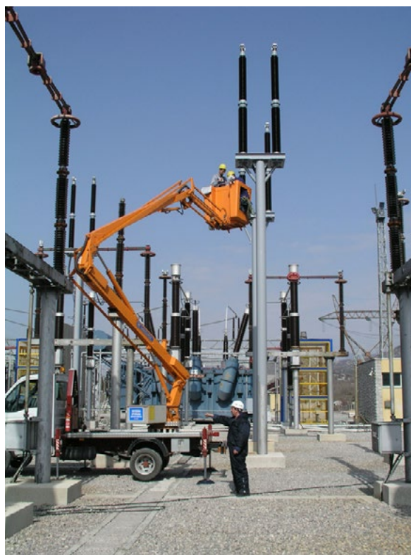
Slika 5.3. Montiranje VN prekidača i ostale energetske opreme
