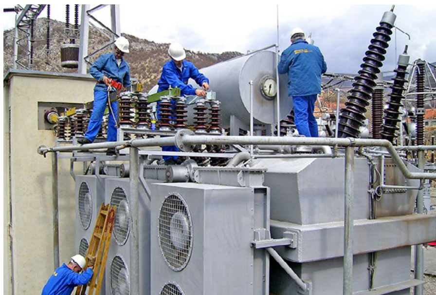
Slika 5.7. Završni radovi na montiranju energetskog transformatora
