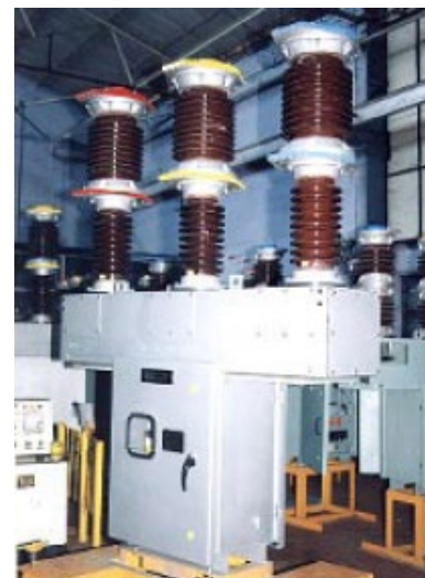
Slika 1.34. Izgled 10 kV vakuumskog prekidača
