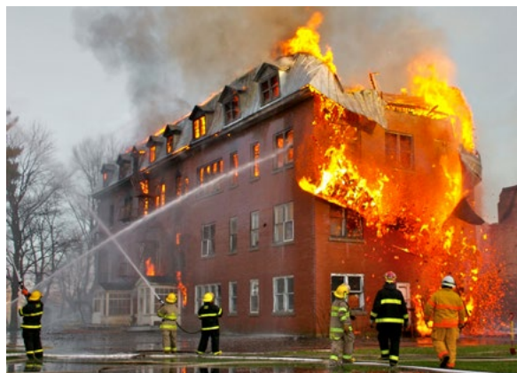
Slika 4.6. Posljedice kratkog spoja u električnim instalacijama objekta
