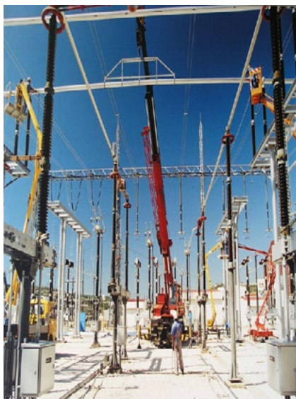
Slika 5.1. Montaža elemenata visokonaponskih razvodnih postrojenja
