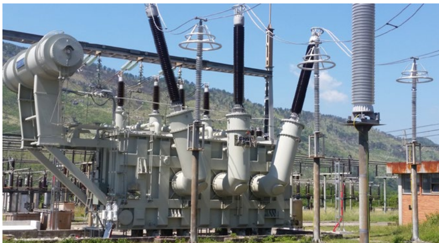
Slika 2.2. Trofazni uljni visokonaponski transformator 400/110 kV (prenosna mreža)
