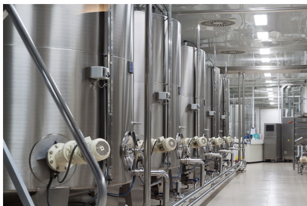
Moderna fabrika za proizvodnju vina
