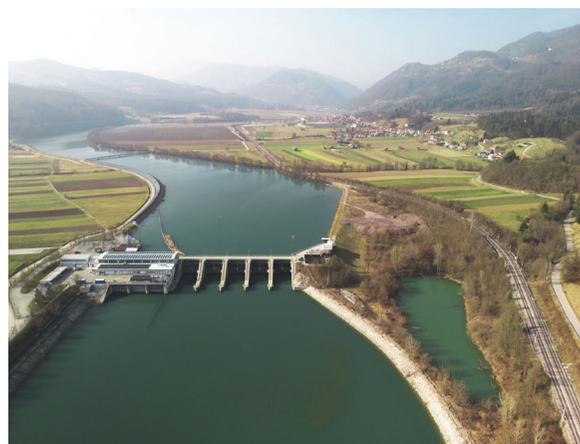
Slika 2.19. Protočna hidroelektrana
