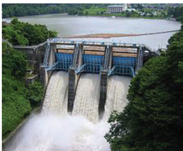
Slika 2.16. Različiti oblici preliva preko masivnih brana
