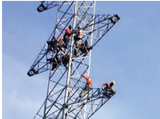
a) dalekovodni stub
