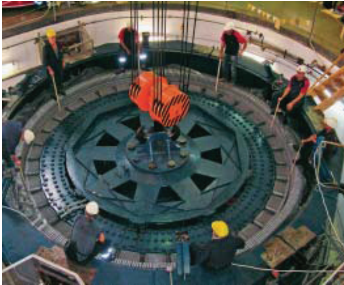
Slika 2.35. Ugrađivanje rotora hidrogeneratora
