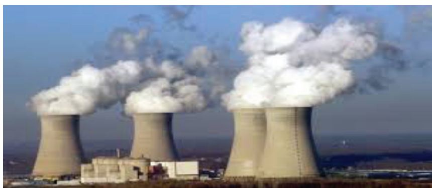
Slika 5.6. Nuklearna termoelektrana u pogonu
