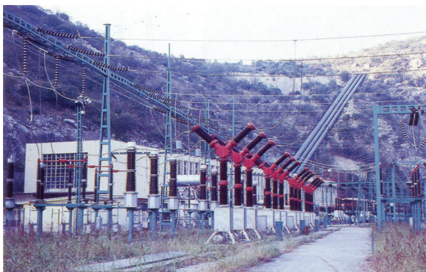
Slika 6.8. Mašinska zgrada i visokonaponsko razvodno postrojenje HE Perućica
