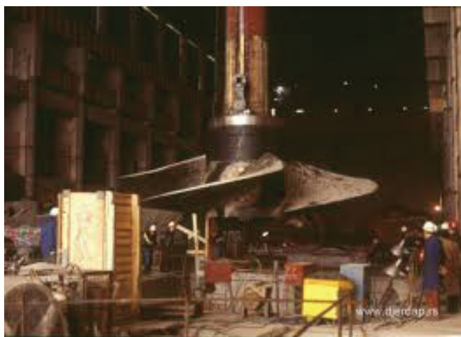
Slika 4.4. Montiranje rotora turbine i generatora u hidroelektrani
