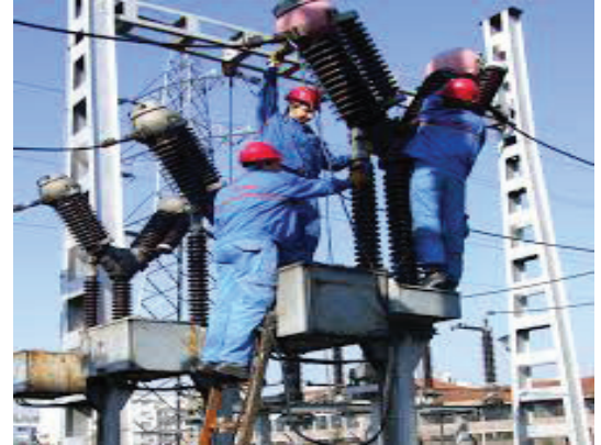
b) visokonaponsko razvodno postrojenje
