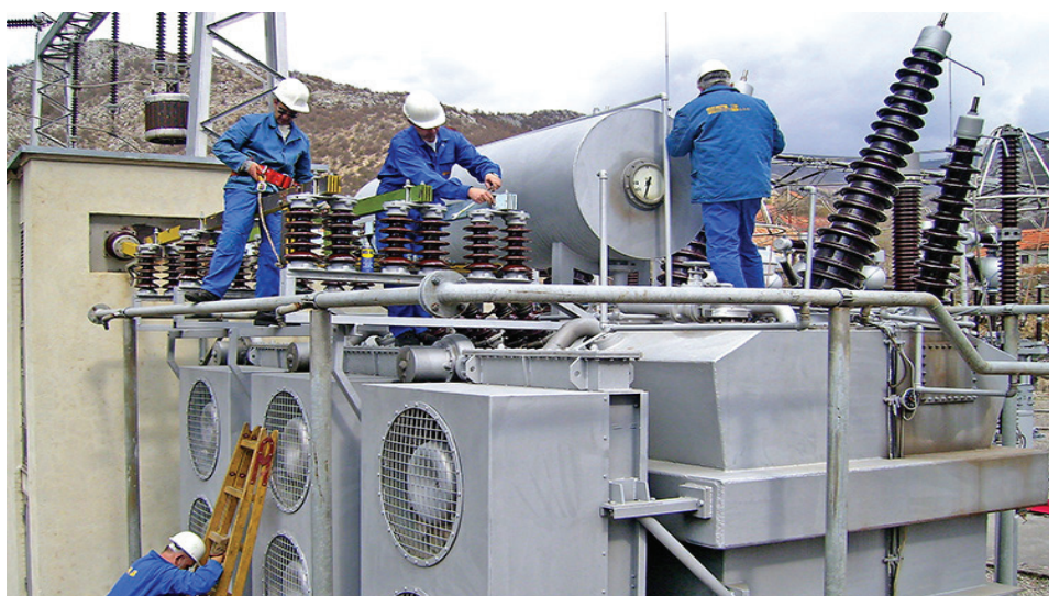
Slika 4.3. Montaža energetskog transformatora
