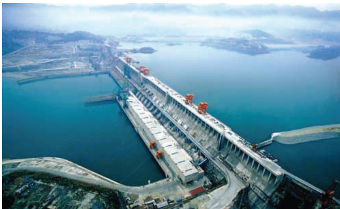
Slika 1.18. Hidroelektrana Three Gorges (Kina)
