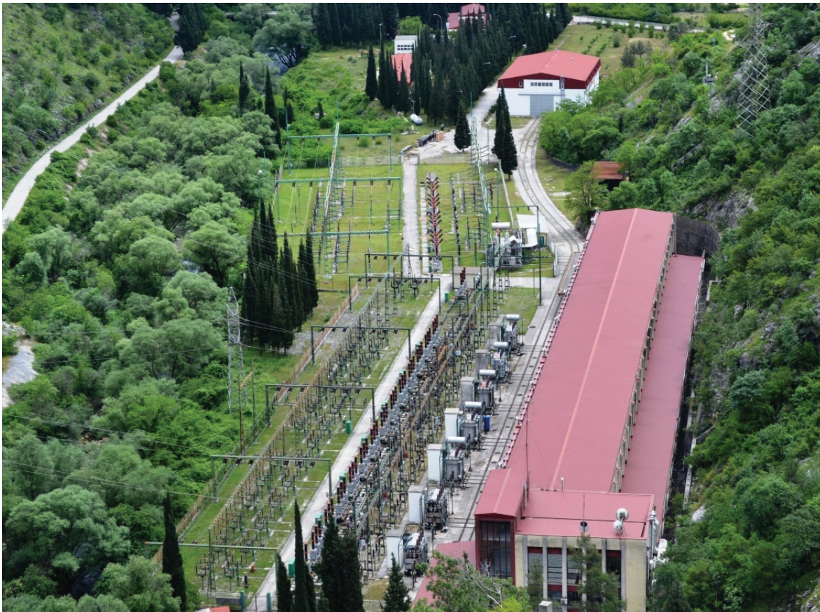
Slika 6.6. Mašinska zgrada i visokonaponsko razvodno postrojenje HE Perućica
