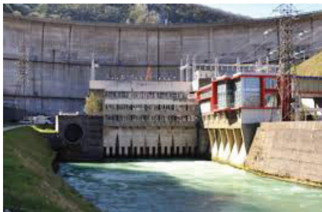
Slika 2.37. Odvod vode kod hidroelektrana
