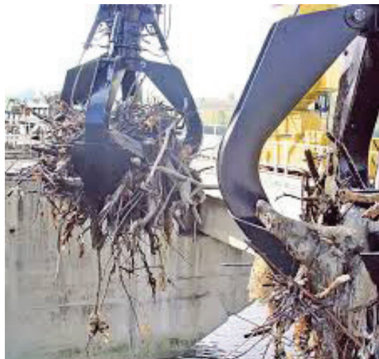
Slika 2.38. Čišćenje rešetke od nanosa na vodozahvatu akumulacije
