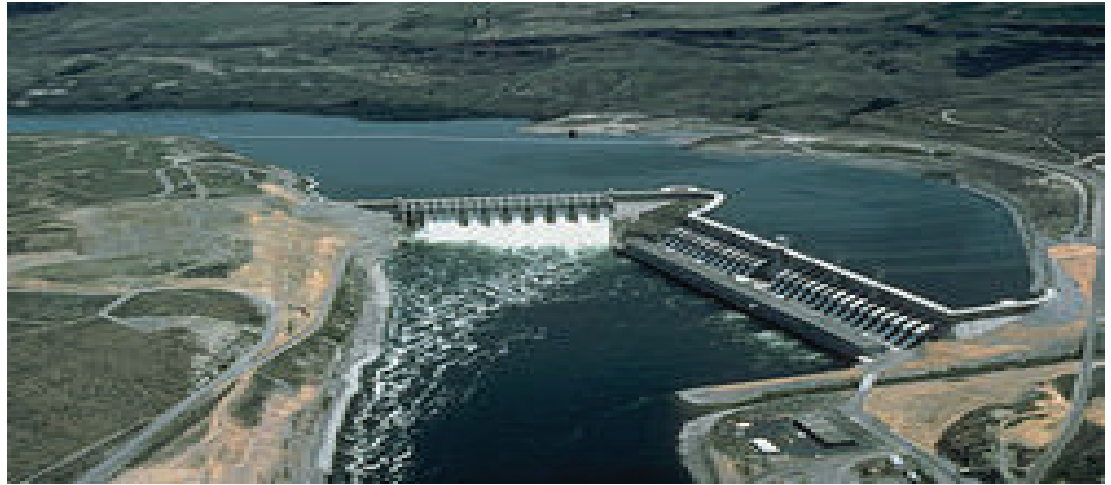
Slika 2.9. Izgled protočne hidroelektrane (Chief Joseph Dam - SAD)
