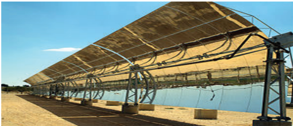
Slika 3.13. Parabolično ogledalo za sakupljanje solarne energije
