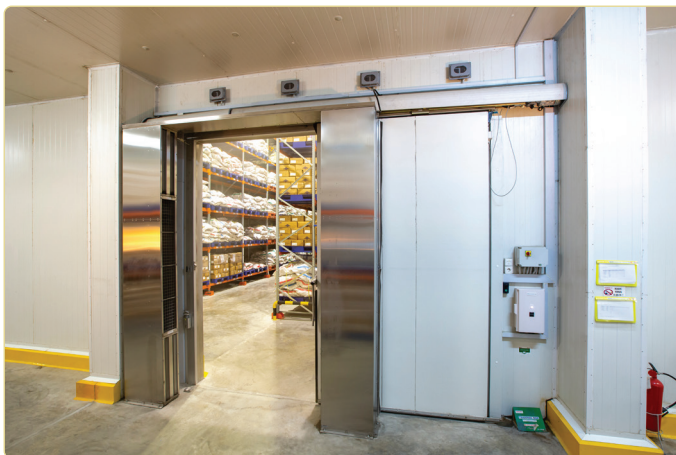
Slika 5.4. Komora za hlađenje
