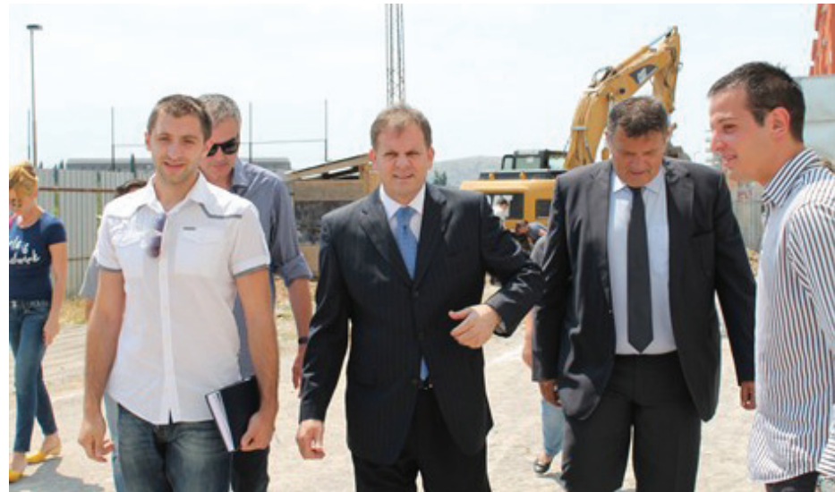
Predstavnici resornih institucija konstatovali da se radovi izvode kvalitetno
